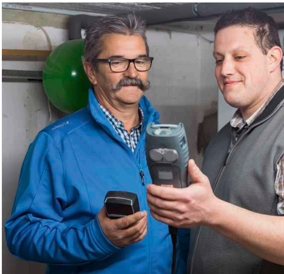
Die Daten der neuen Heizungsanlage stimmen: Premium-Partner Markus Frost (rechts) und NGW-Energieberater Karl Heinz Derichs sind zufrieden.
